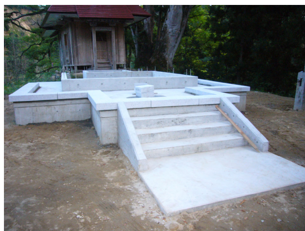
神社建設・基礎ができた (9/2撮影)
